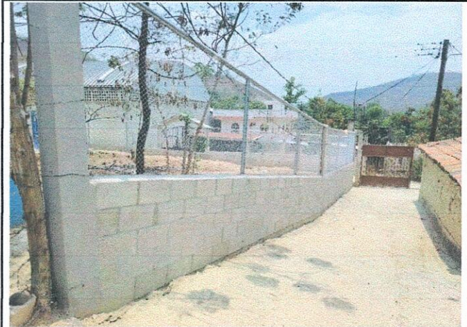
Foto 2: CERRAMIENTO MURO PERIMETRAL DEL CENTRO EDUCATIVO, FINALIZADO
