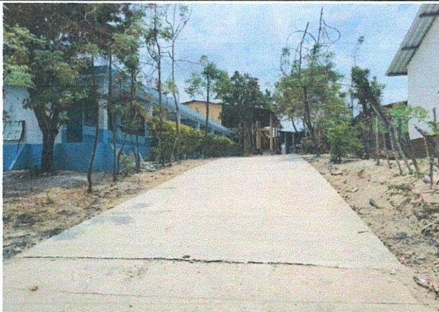
Foto 3: MEJORAMIENTO DE LOSA DE PATIO EN EL AREA DE INGRESO AL PLANTEL, FINALIZADO
