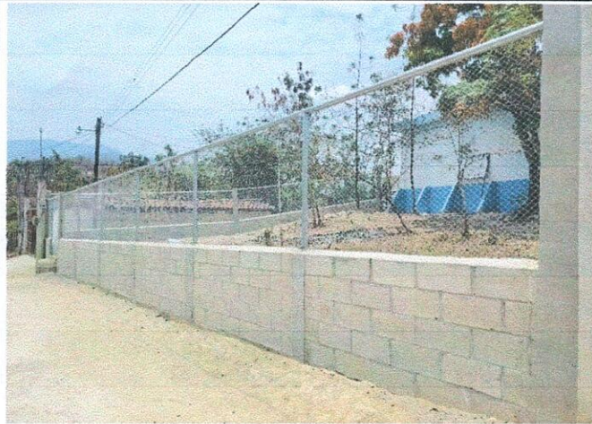
Foto 1: CERRAMIENTO MURO PERIMETRAL DEL CENTRO EDUCATIVO, FINALIZADO
